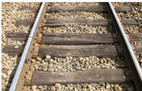
Rails courts sur traverses bois
