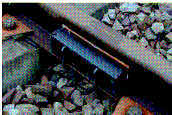
Exemples d'absorbeurs sur rail (Corus et Socitec)
