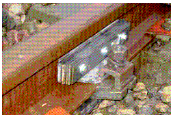
Exemples d'absorbeurs sur rail (Corus et Socitec)
